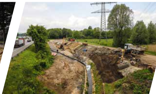
Boye-Renaturierung nördlich der A2, Bottrop/ Gladbeck
