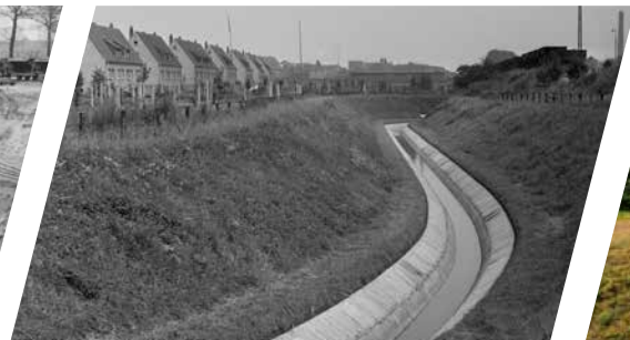
Offene Schmutzwasserläufe mit Betonkorsett
