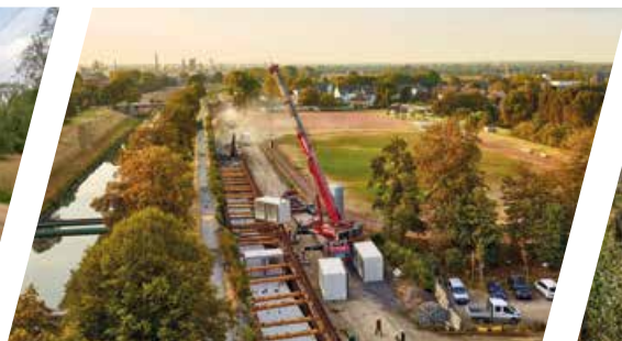
Verlegung des Abwasserkanals Emscher in Oberhausen
