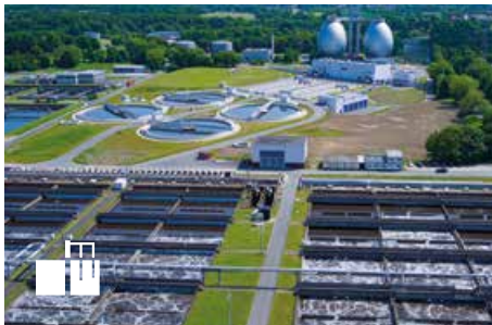
Kläranlage Emscher-Mündung in Dinslaken
