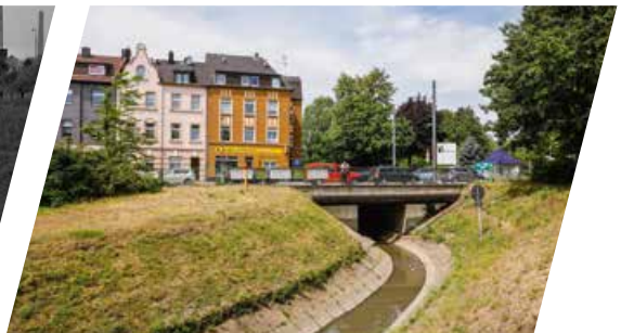
Vor der Haustür fließt das Abwasser
